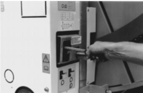
Das Entspannen erfolgt durch vorsichtig dosiertes nach unten drücken des Schalthebels.
