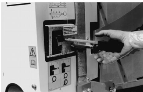
Abschalthebel in die Abschaltstellung ziehen ...
