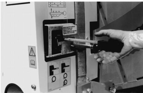
2. Abschalthebel in die Abschaltstellung ziehen und durch langsames, vorsichtiges nach unten ...
