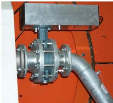
Mit der Abschaltklappe-Überdruck wird am Ende des Beregnungsvorganges die gesamte Wasserzufuhr unterbunden. Schließt das Ventil, steigt der Druck in der Zuleitung an.
